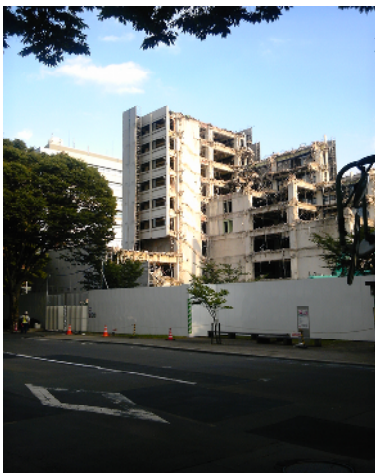
取り壊し作業中の建築・土木研究棟 (H24.8.6撮影)
