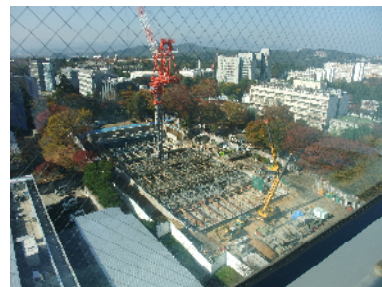
基礎工事中の建築系研究棟(13年10月30日)
